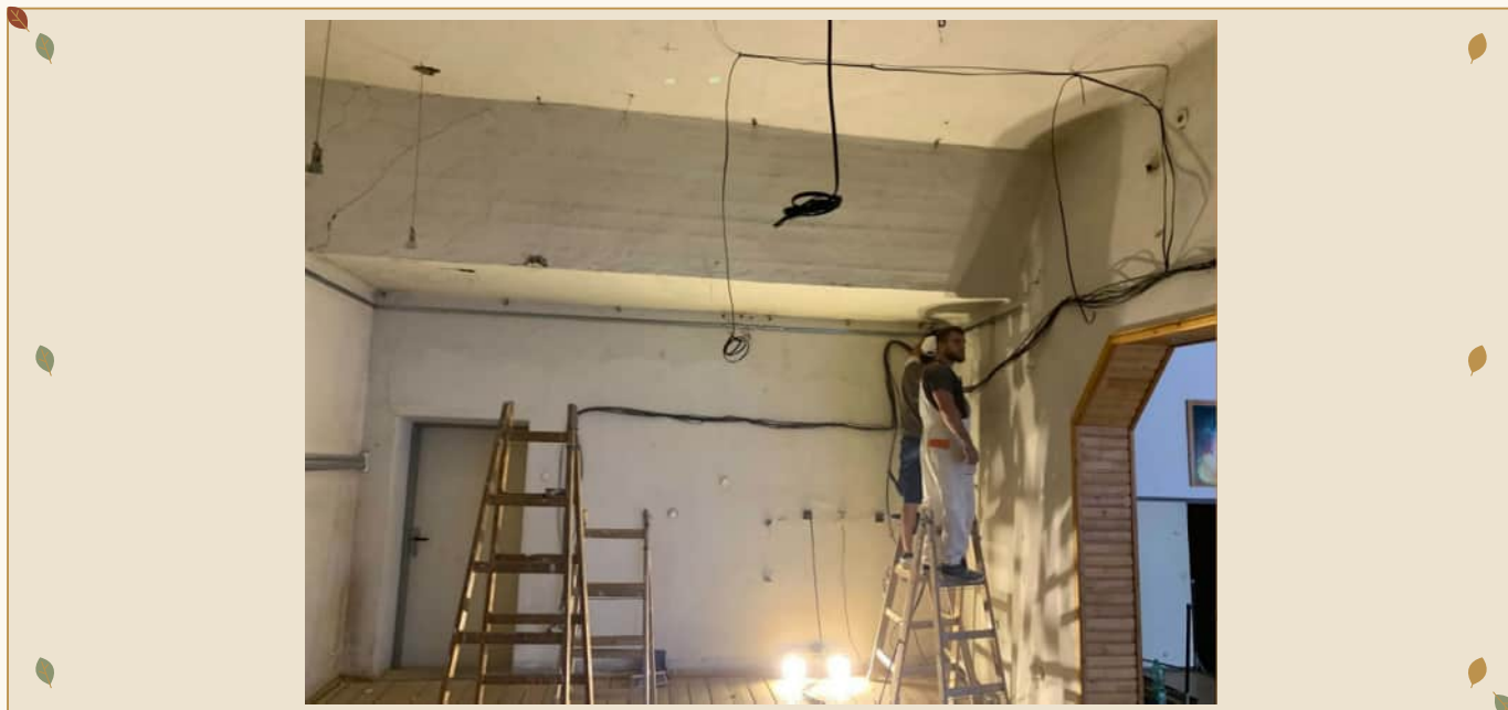
Práce na elektroinštalácii pri obnove pódia.
