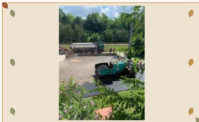
Asfaltovanie pri okraji novej plochy.
