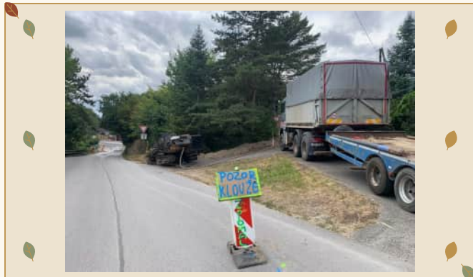
Technika pri budovaní optickej siete.
