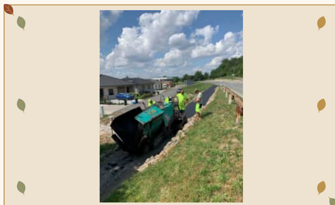
Asfaltovanie chodníka pri trativode
