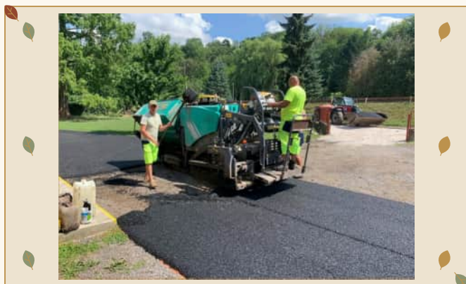
Pokládka nového asfaltového povrchu.
