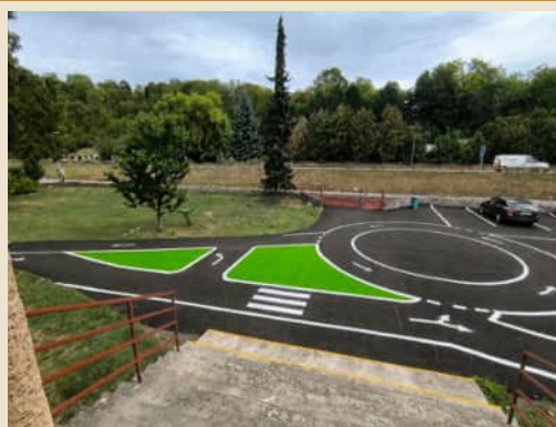
Nové dopravné značenie na hotovej ploche.
