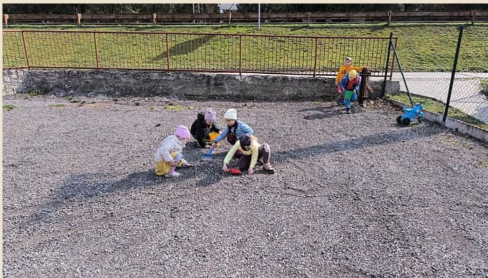
Príprava podkladu na školskom dvore pred vznikom dopravného ihriska - deti sa už nemusia hrať v špinavom štrku.
