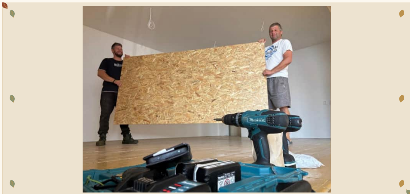
Príprava novej podlahy na pódiiu.
