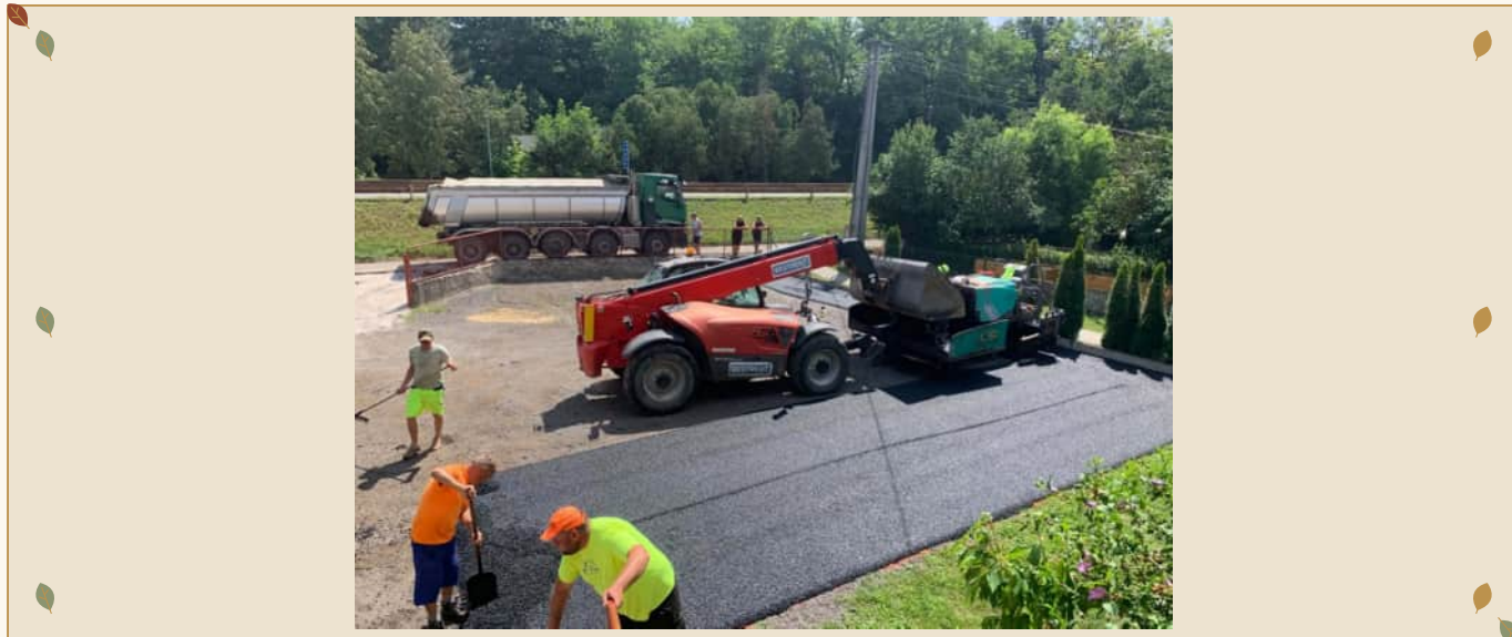
Postupné asfaltovanie plochy na školskom dvore.
