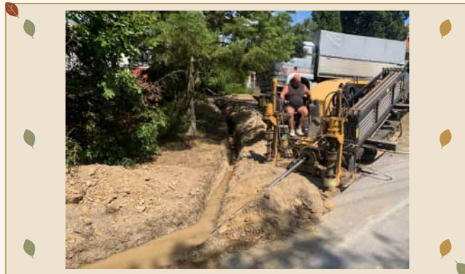
Strojové práce pri ukladaní vedenia.
