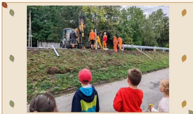
Práce na zvodidlách pri ceste.
