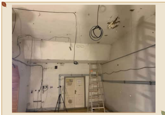
Pódium počas rekonštrukcie.
